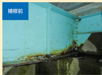
橋梁の鋼桁補修事例 (当て板補修)
