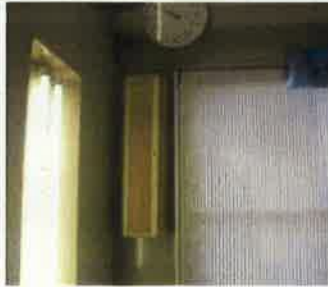
▲エアコン設置
