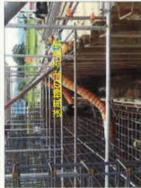
▲散水による現場の温度低下
