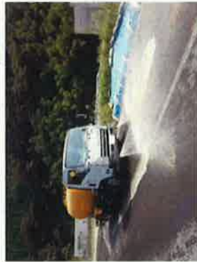
▲散水による現場の温度低下
