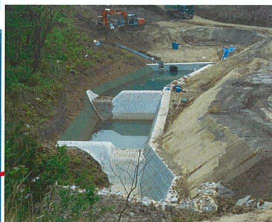
防災工事：沈砂池設置
