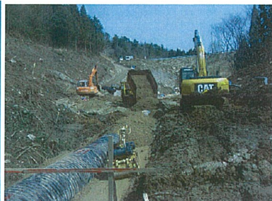
防災工事：暗渠設置
