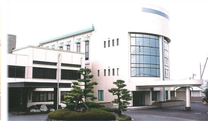
建設情報プラザオープン（平成8年2月）
