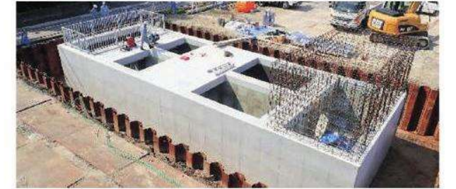
龍島ポンプ場建設工事現場技術監理業務 (湯梨浜町)
