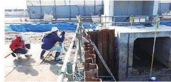
渡漁港内水排除施設築造工事（流入路工） 現場技術業務（境港市）
