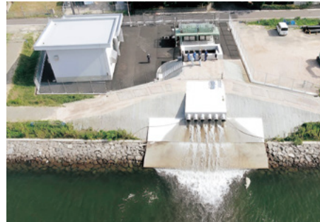
龍島ポンプ場 建設工事現場 技術監理業務 (湯梨浜町)
