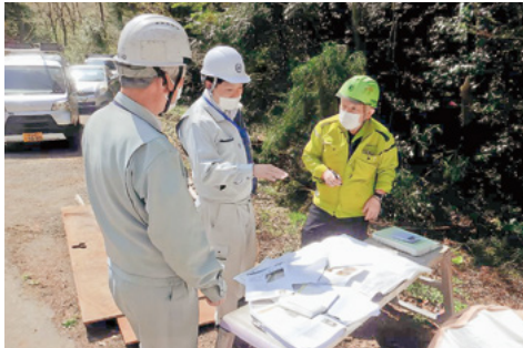
橋梁補修現場 技術業務 (倉吉市)
