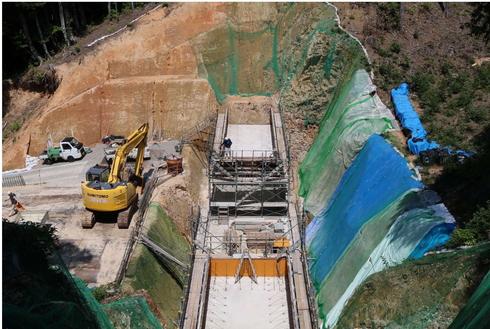
撮影場所(倉吉市 砂防ダム)
