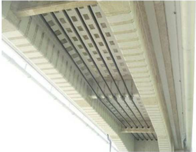
写真1 外ケーブル補強・炭素繊維シート補強
