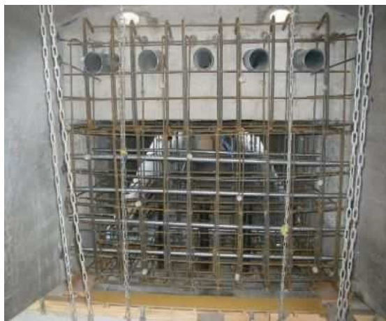
既設横桁に 鉄筋・シース組み立て状況
