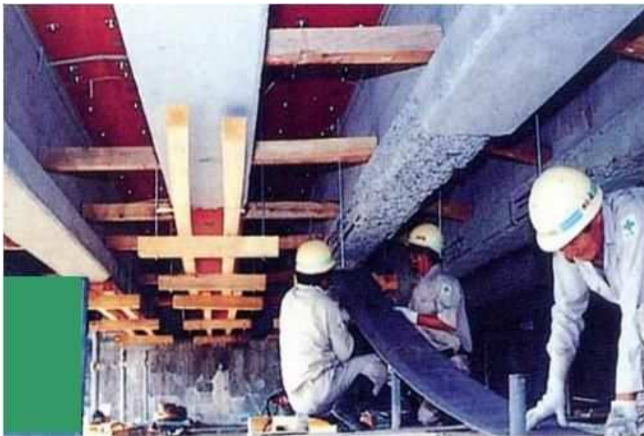
主桁下面の鋼板接着
