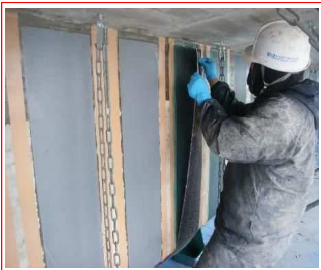
炭素繊維シート接着状況
