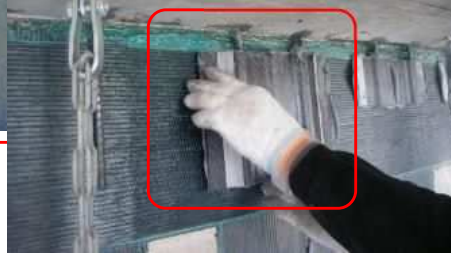
CFRPロッド+プレートによる固定状況
