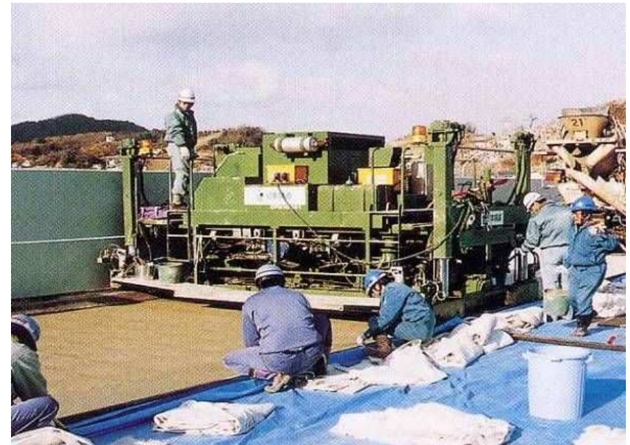
鋼繊維コンクリート打設状況
