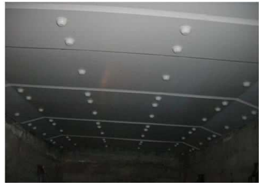
床版下面の鋼板接着
