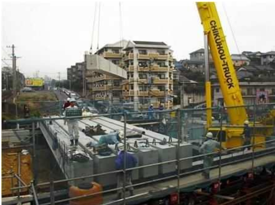
主桁の架設状況
