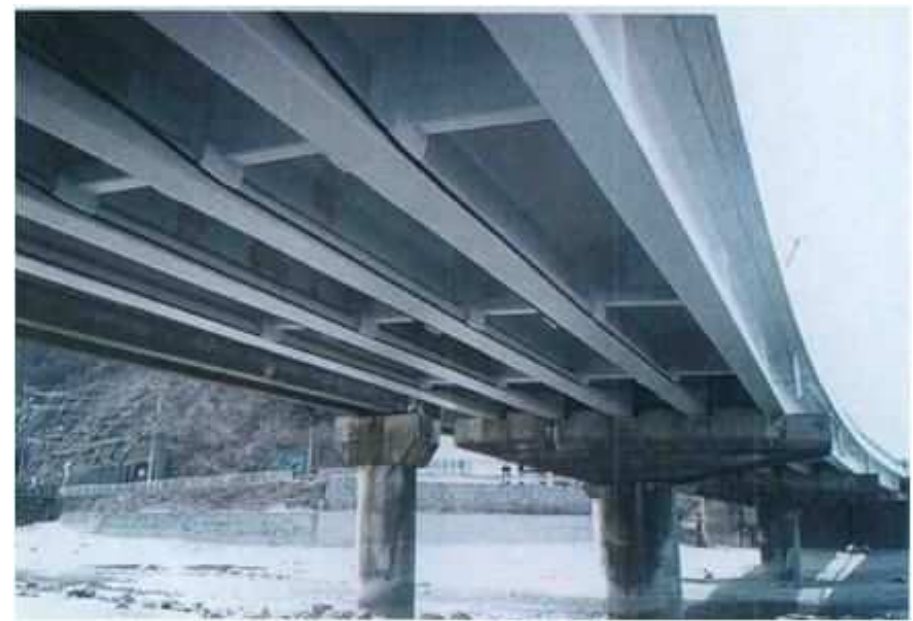
外ケーブル工法 施工例
