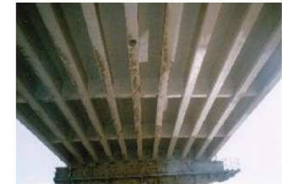
写真1 橋梁下面全景
