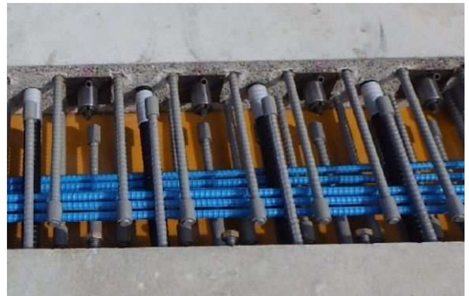
写真3 PC鋼材定着
