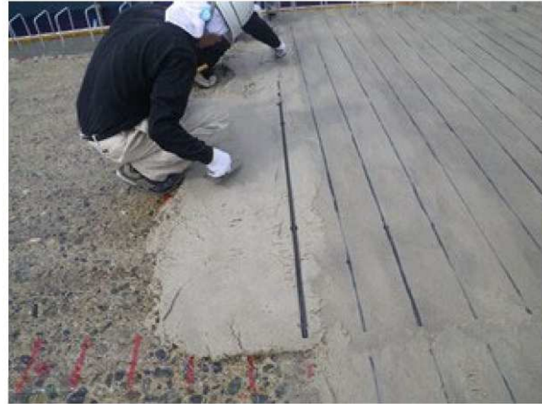
写真2 CFRP ロッドと樹脂モルタルによる床版上面補強
