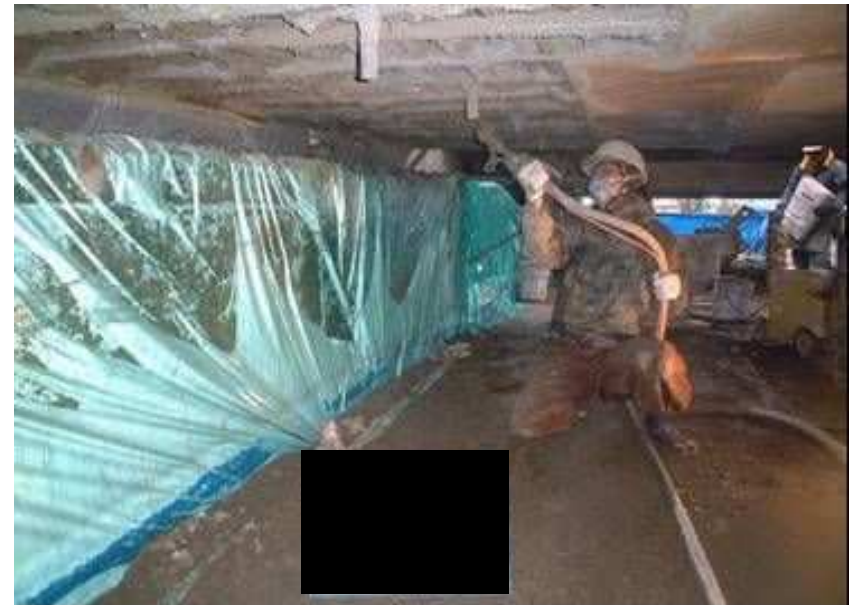
吹き付けによる断面修復の状況
