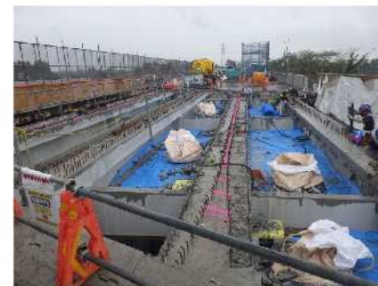
写真1 既設床版撤去完了状況
