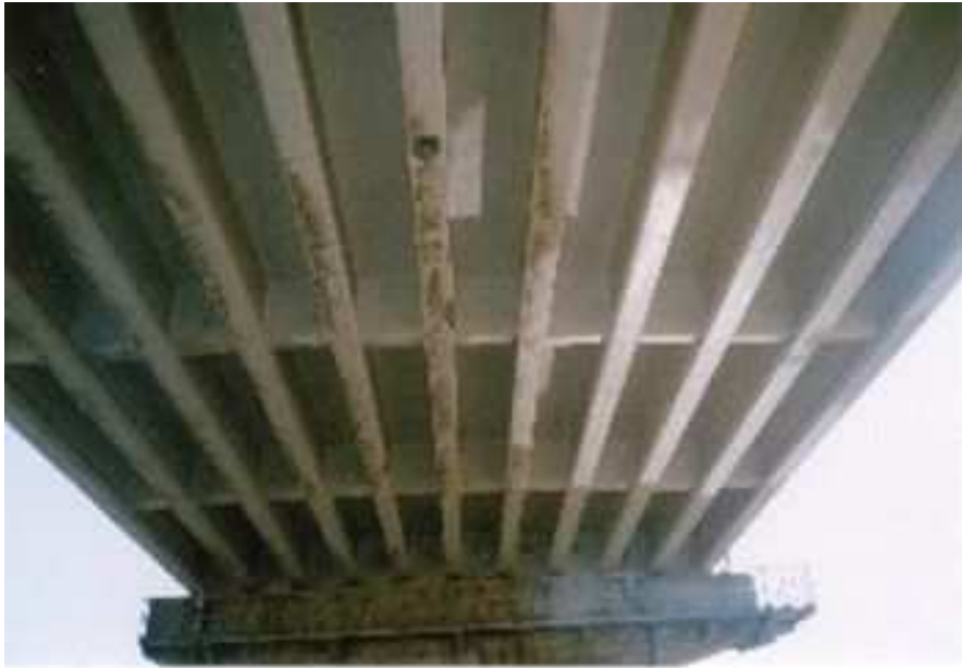
写真1 橋梁下面全景
