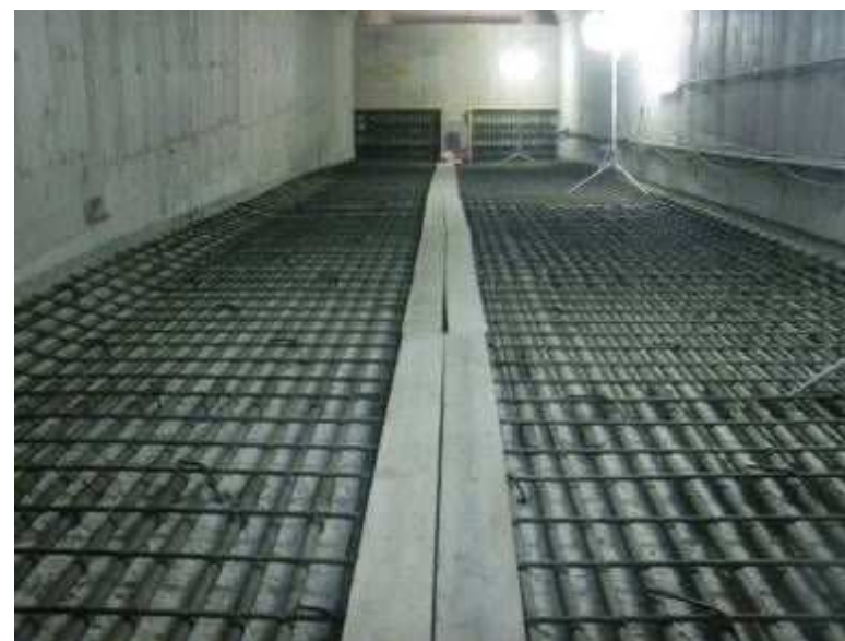
写真1 鉄筋組立状況（箱桁内下床版上面）
