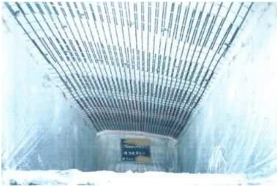
補強筋配置状況
