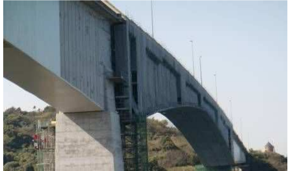
写真2 吊足場の状況（内部に吹付機材を配置）
