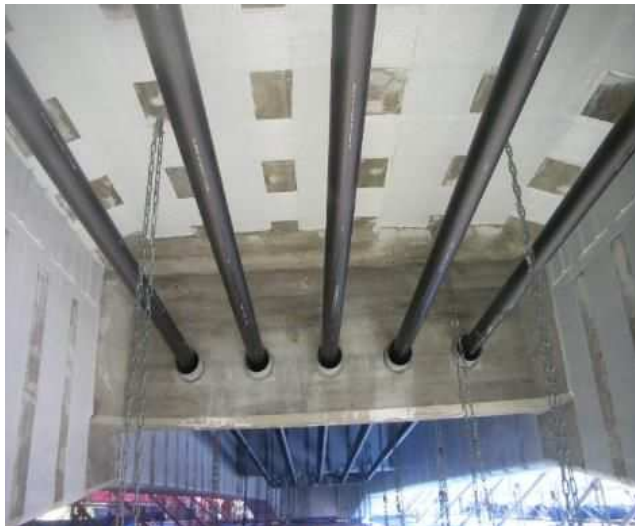
外ケーブル配置状況
