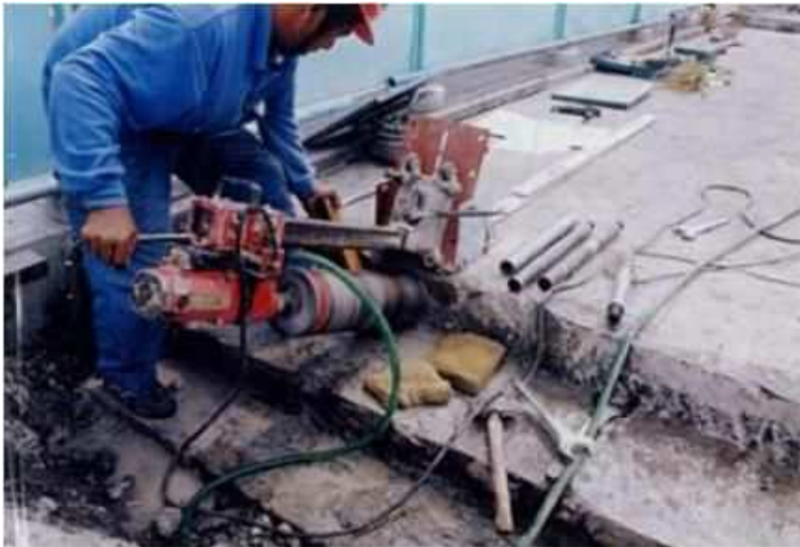
主桁間の削孔状況
