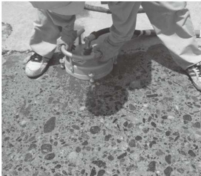
下地処理状況
