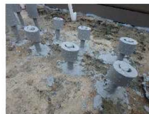
写真3 圧着定着完了状況
