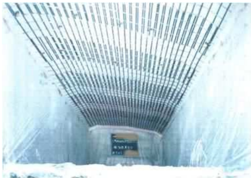
補強筋配置状況
