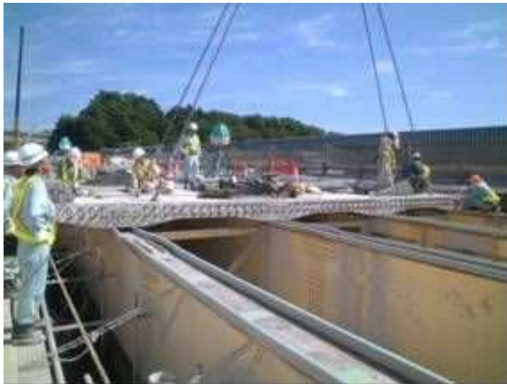
プレキャストPC床版設置
