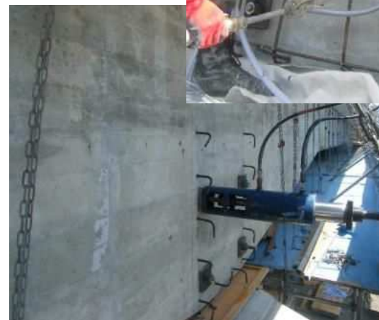
緊張・グラウト状況
