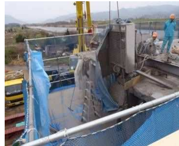
ワイヤーソーによる切断状況
