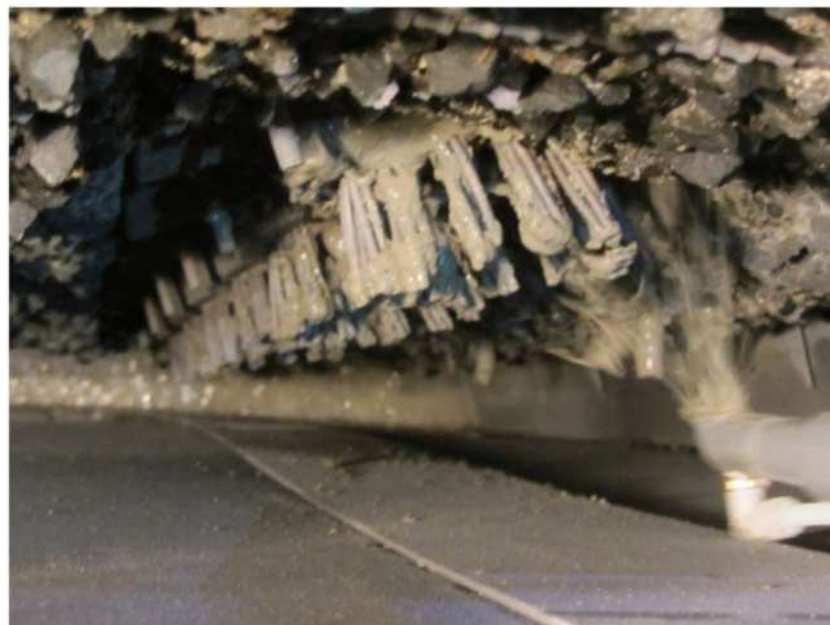
写真5 ハツリ後のPC鋼材定着部
