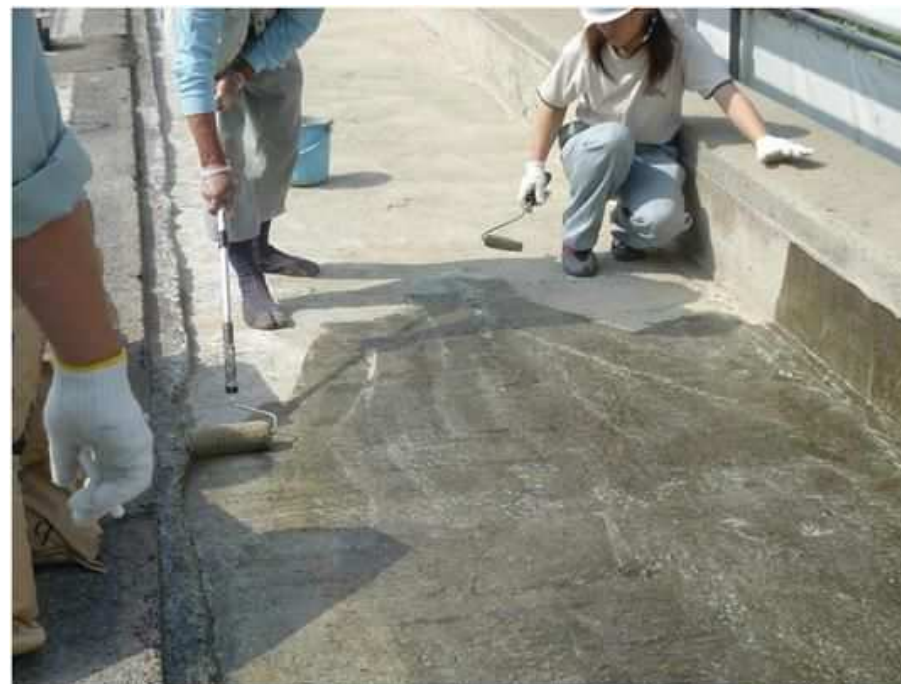
塗膜系橋面防水工の例
