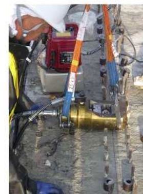
写真2 圧着鋼管定着作業状況
