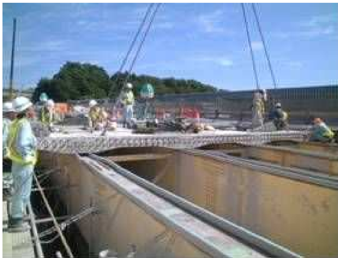
プレキャストP C床版設置状況
