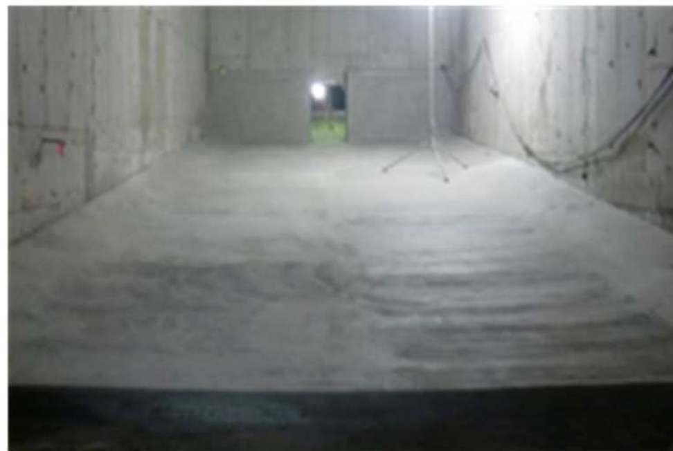
写真3 吹付け完了（箱桁内下床版上面）
