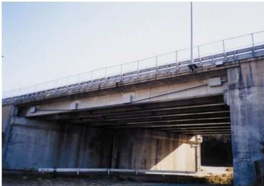
外ケーブル工法 施工例
