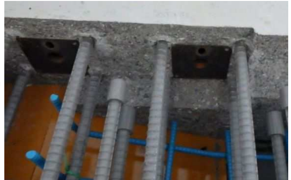
写真1 間詰め部の定着プレート
