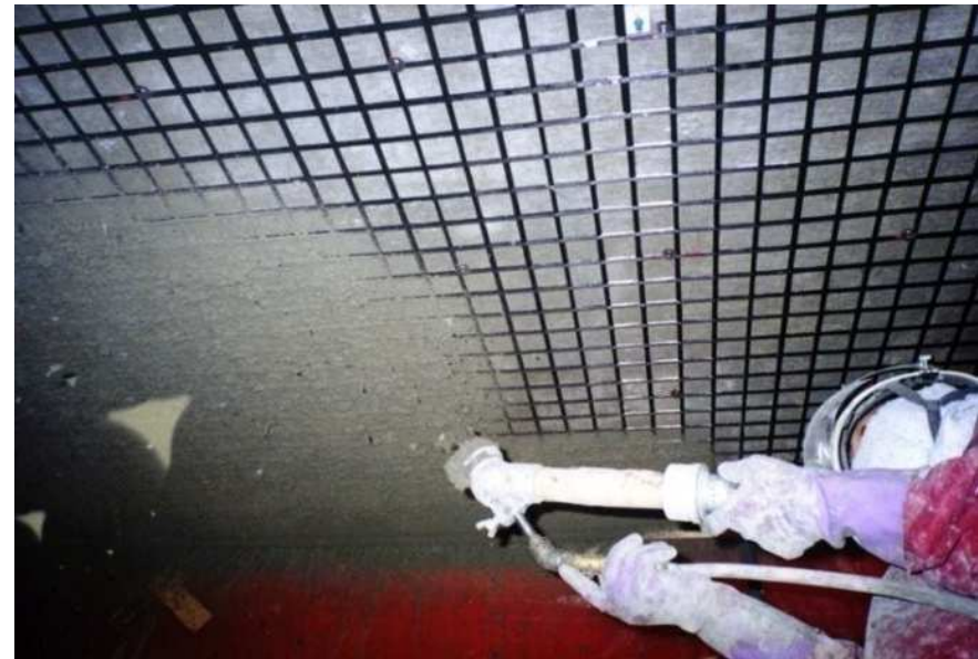
ポ リマーセメントモルタル吹付け状況
