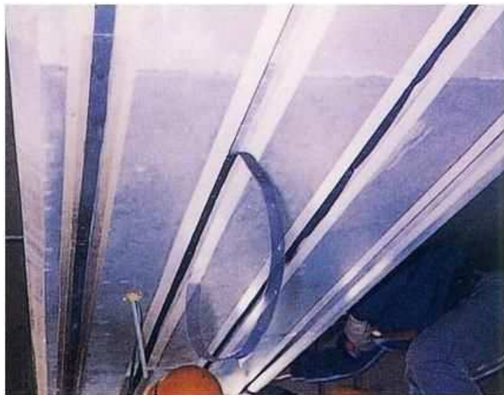
線状陽極材の設置例
