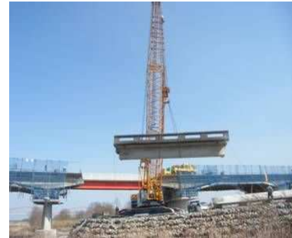
クレーンによる吊り桁の撤去状況
