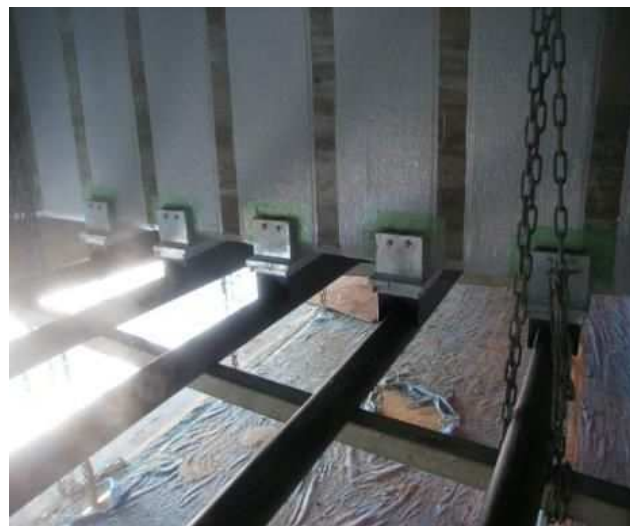
偏向箇所状況
