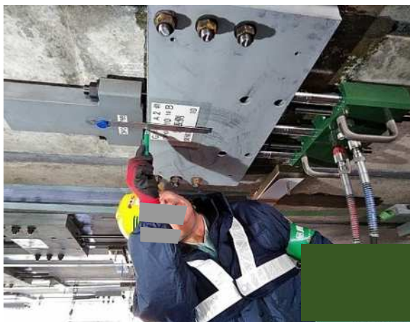
炭素繊維プレート緊張材緊張
