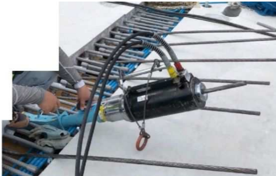
写真2 PC鋼材緊張
