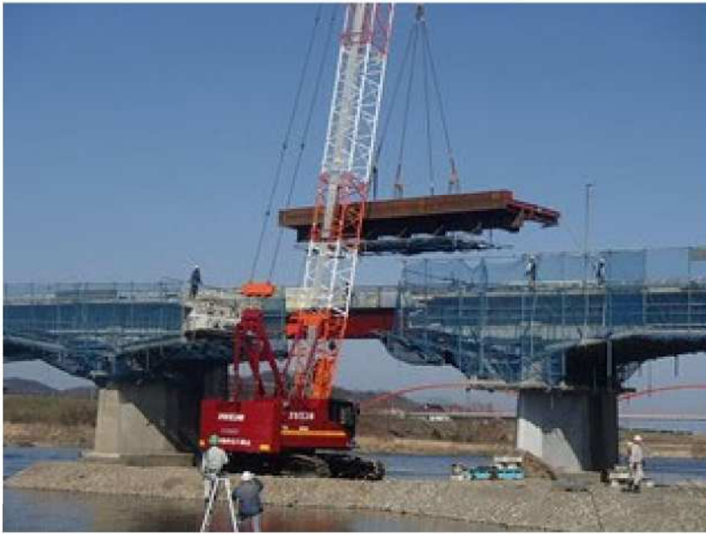
写真3 鋼製吊り桁の架設状況
