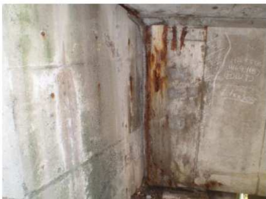
写真1 桁端部主桁側面
