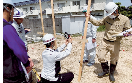
丁張り研修 (現場実習)
