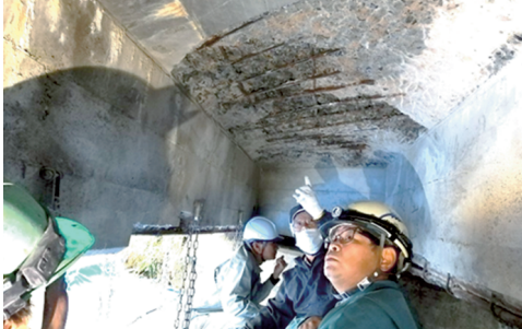
橋梁補修現場 技術(八頭町)
