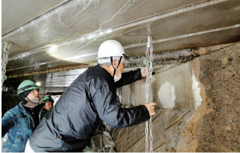
橋梁補修現場 技術(八頭町)
