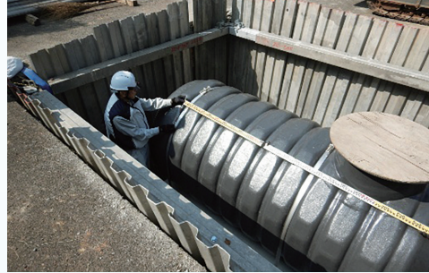
マンホールトイレ 整備工事 現場技術(倉吉市)
