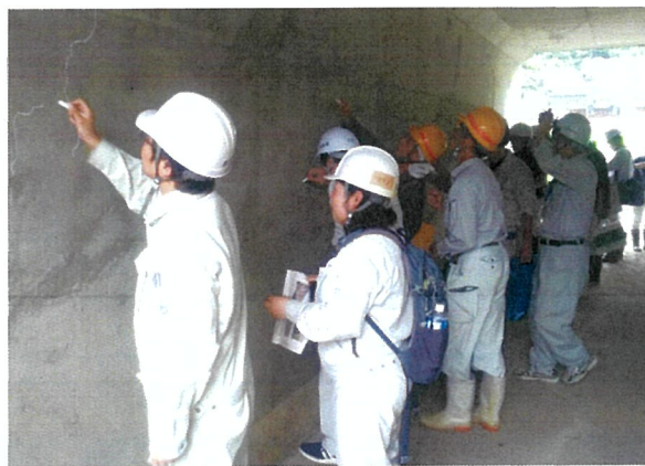
「道路橋点検診断」研修の様子
