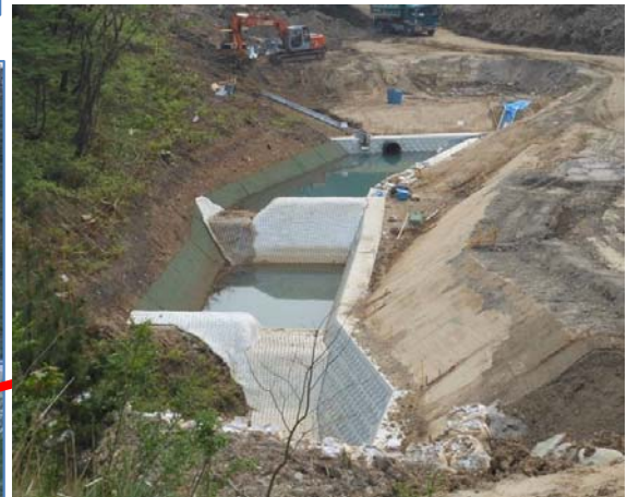
防災工事：沈砂池設置
