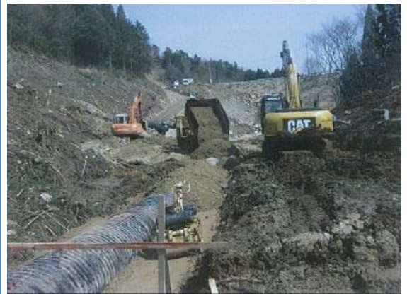
防災工事：暗渠設置
