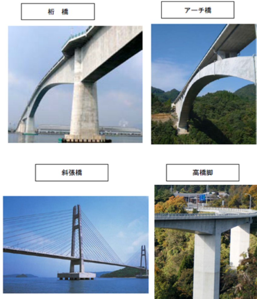
図 2.2.1 近接目視点検に大規模な足場の設置が必要となる橋梁の一例
