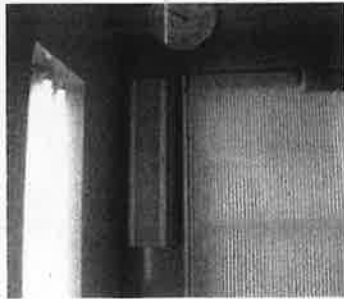
▲エアコン設置
